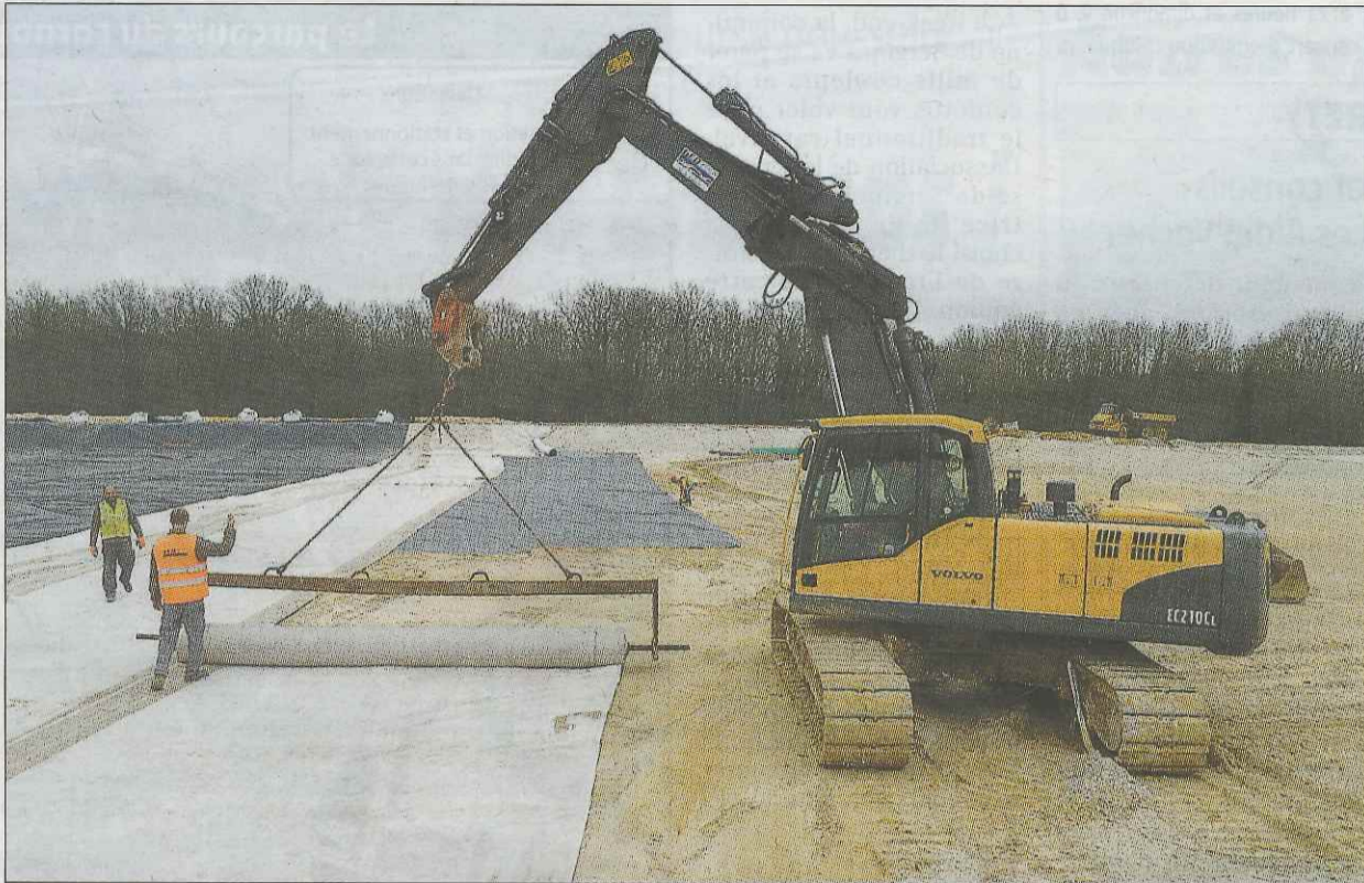
PRÉPARATIF. Les entreprises spécialisées ont posé les géotextiles et la géomembrane du nouveau casier, la semaine précédente. O. R.
